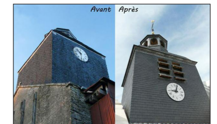
Vue de l'église avant et après refecton
