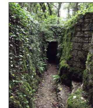
Vue de l'Acqueduc
