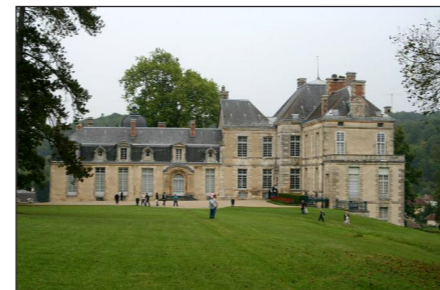
Vue de la façade du château
