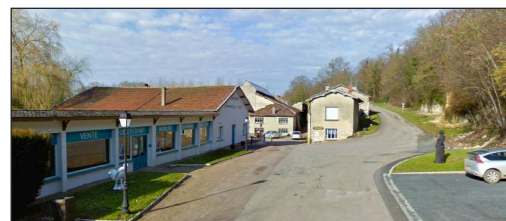
Vue de l'entrée de l'ancienne fonderie
