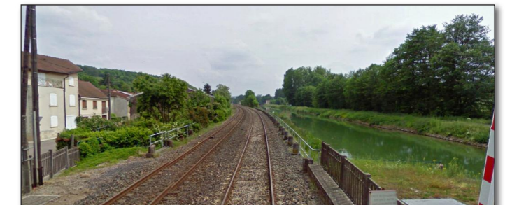
Vue de la voie ferrée et du canal, dans la vallée de la Marne, à Vecqueville
