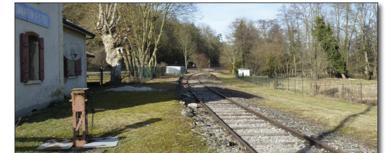
Voie ferrée (Saint-Dizier - Doulevant-le-Château), à Dommartin-le-Saint-Père
