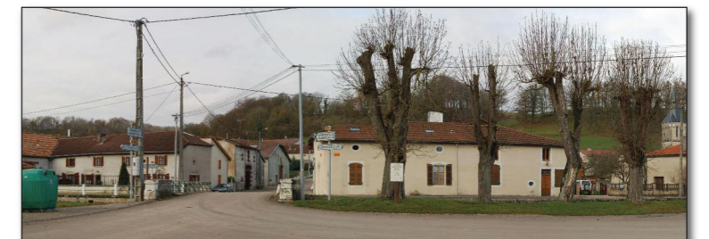
Lignes électriques, depuis le centre de Leschères-sur-le-Blaiseron
