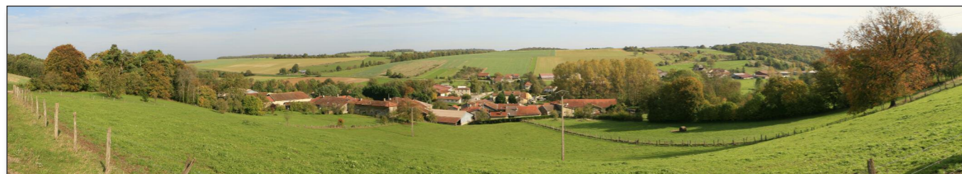
Vue du village de Baudrecourt, implanté en fond de vallée
