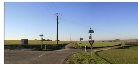
Ligne BT, en bordure de la RD16, à Maconcourt
